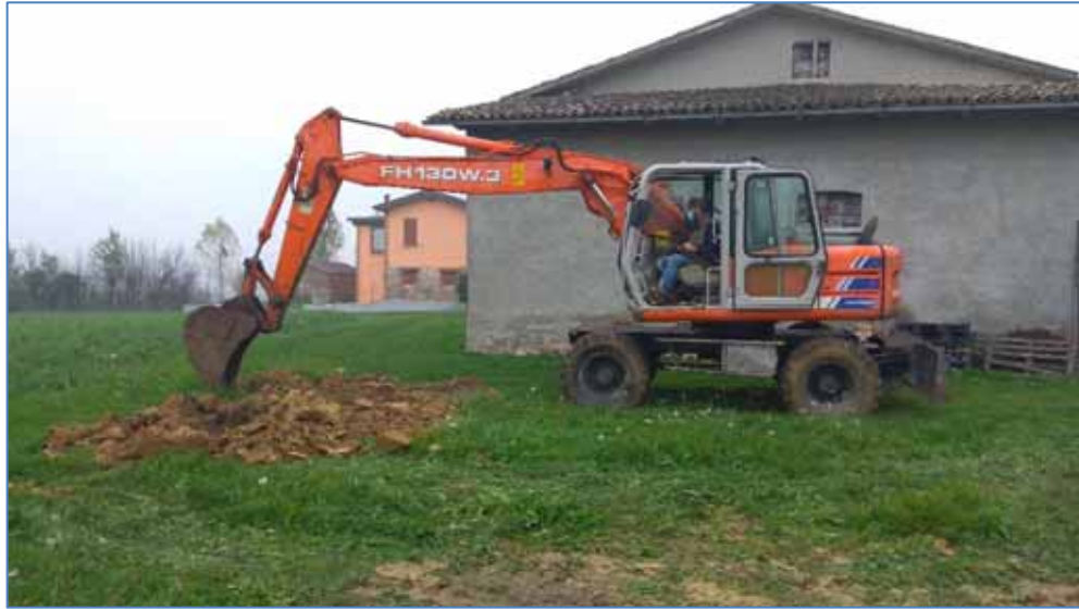
Foto 5: saggio esplorativo n°2 realizzato nell'area di sedime di un nuovo fabbricato di progetto
