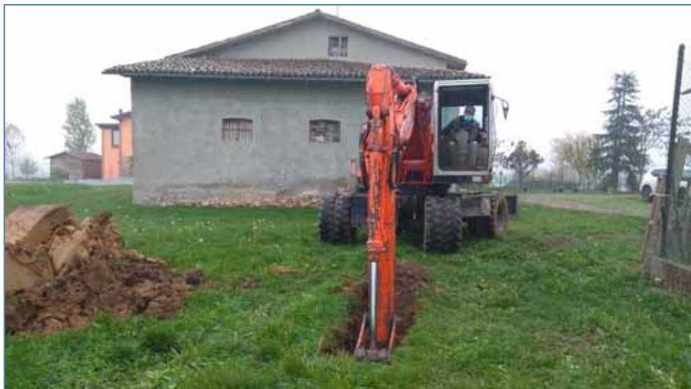
Foto 4: Saggio esplorativo dei primi 3 metri di terreno (in corrispondenza del sondaggio D1)
